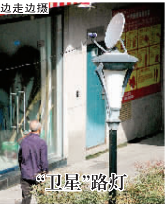
周口市五一广场，一根路灯头上顶着一个卫星电视锅，不仔细看还以为高科技“卫星”路灯。这位安装卫星电视锅子的主人真会“动脑筋”。 晚报记者 朱海龙 摄
