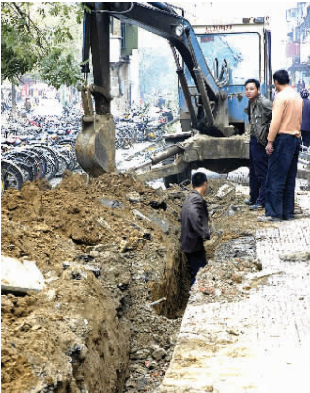
周口市人民路改造工程如火如荼地进行，目前正在展开清除路边的树木、障碍物和挖沟埋管道工作。图为10月13日工人在该路段施工。
