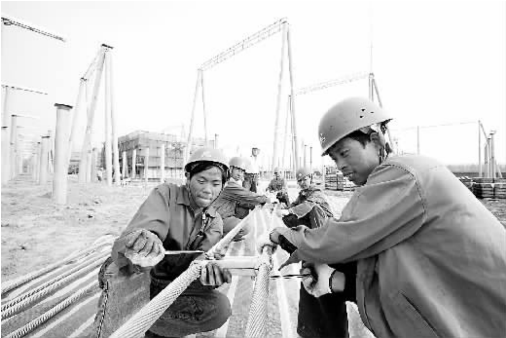
周口谷庄 220 千伏变电站是河南省电力公司重点工程之一，总投资 8620 万元，一期容量为 1 台 180 兆伏安，计划 2009 年 12 月底投入运行。为赶工程进度，自今年 6 月开工以来，工人们主动放弃节假日加班加点。
