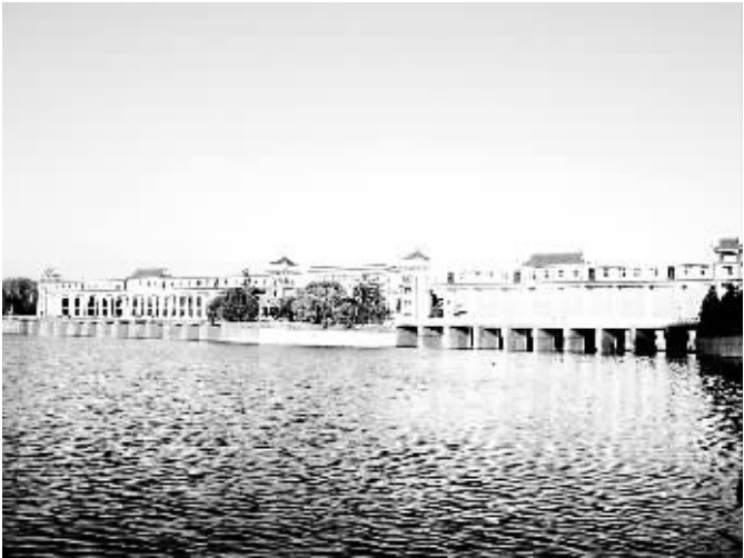
周口大闸全景
