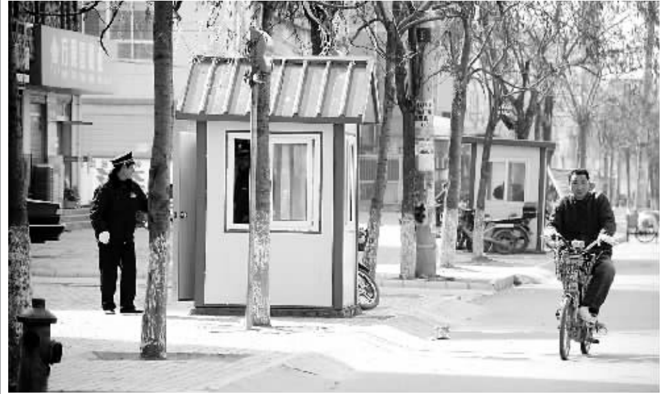
有人在周口市市区汉阳南路某火锅店门前的人行道上搭建了一间临时房。附近市民认为这间临时房有碍观瞻,影响通行,他们希望有关部门对这种路边乱搭乱建现象给予整治。
