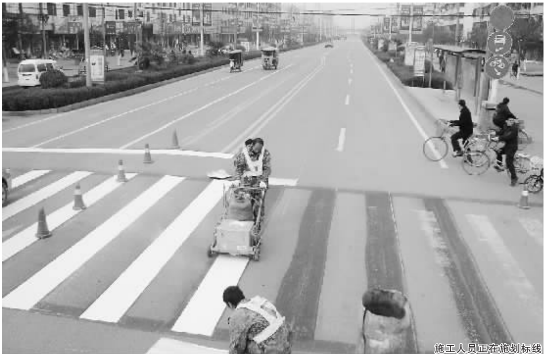
施工人员正在施划标线
