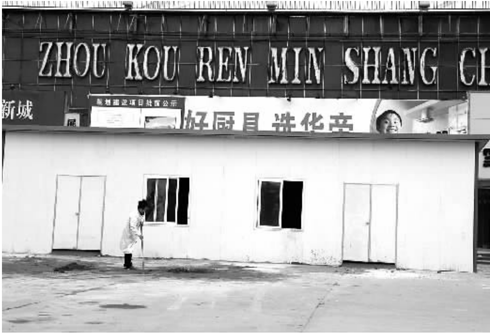
人民商场门前的违法建筑
