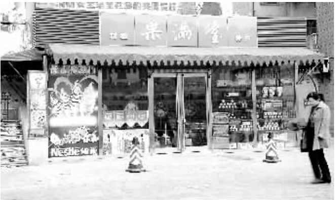
天下诚门前的违法建筑
