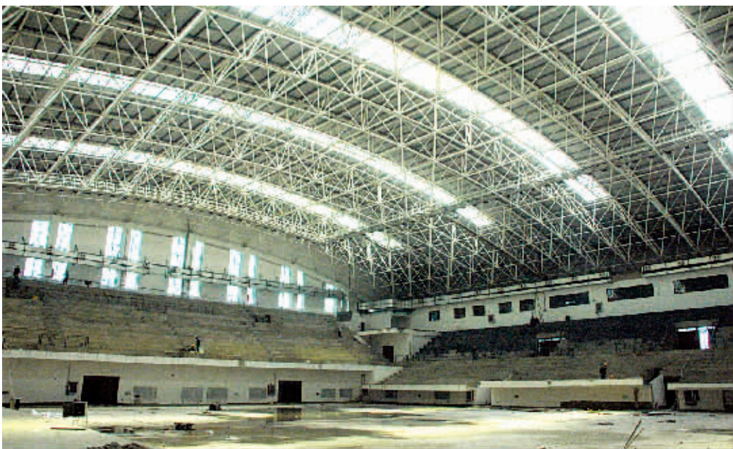
市体育馆内部装饰正在紧张进行
