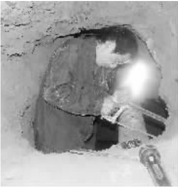
施工人员在艰难地在水洞内挑灯夜战
