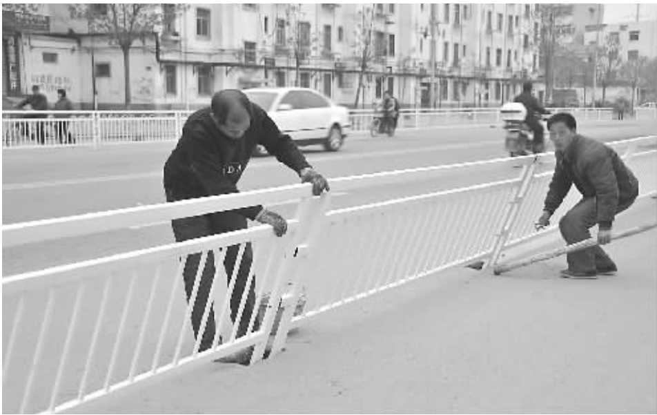
昨天下午,在市区建设路上,两名工人在安装人车隔离护栏。据介绍,由于以前的护栏损坏严重,川汇区投入资金,对建设路上的行车道与人行道隔离护栏升级改造,为行人通行提供安全保障。
