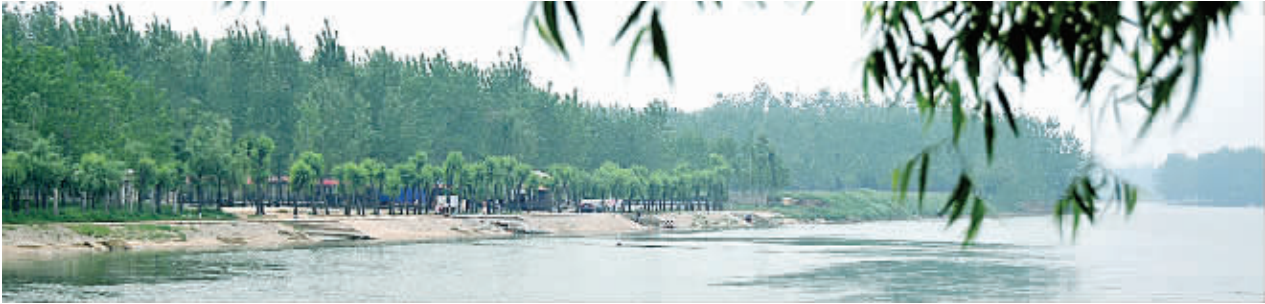
周口橡胶坝拦河蓄水
