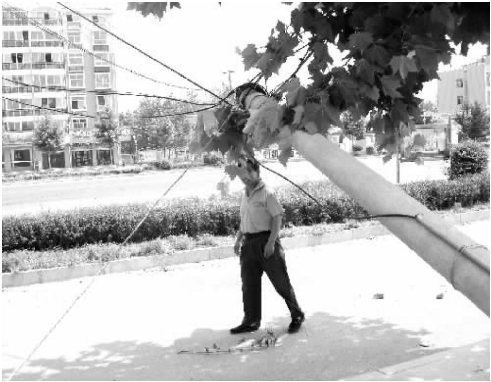
昨日,一名行人小心翼翼地通过倾倒的电线杆。位于西华县迎宾大道附近的一根电线杆倾倒,严重影响着过往行人的安全。
