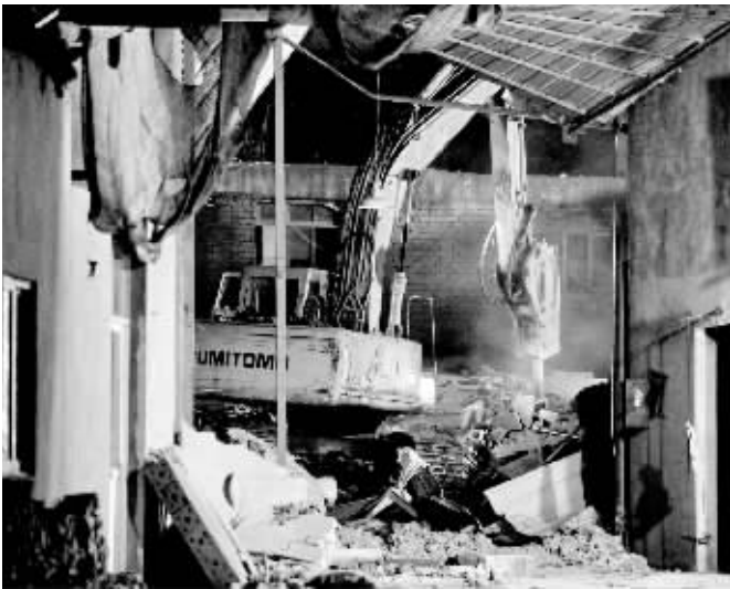
■6日夜,挖掘机在事故现场搜救被埋人员
