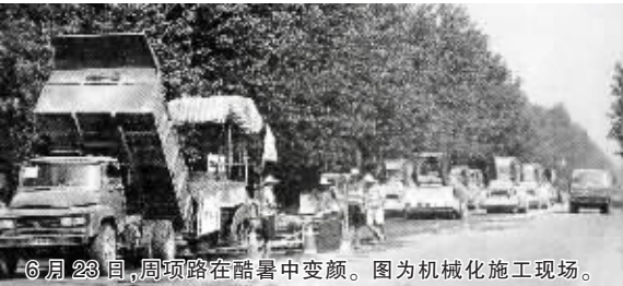
6月23日，周项路在酷暑中变颜。图为机械化施工现场。
