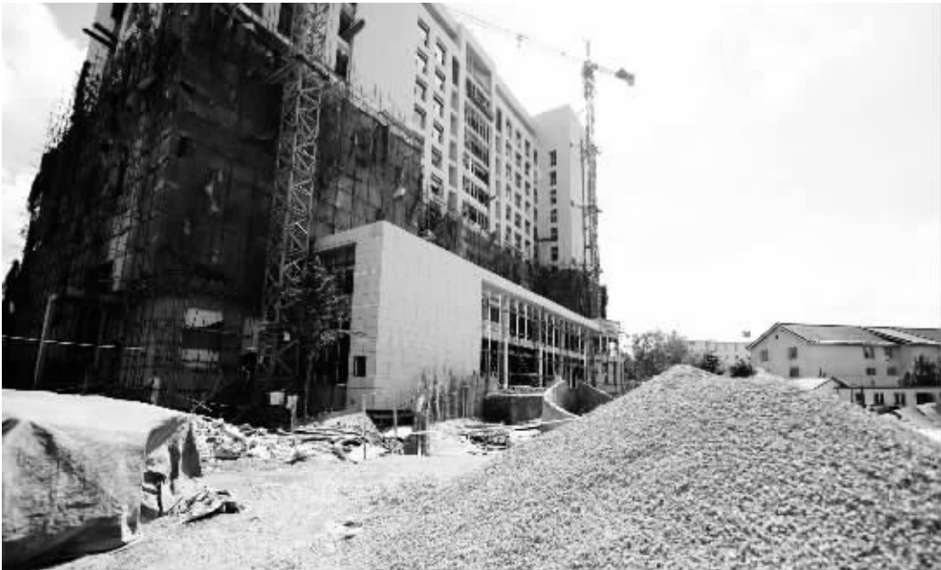
吉林梅河口一建筑工地
