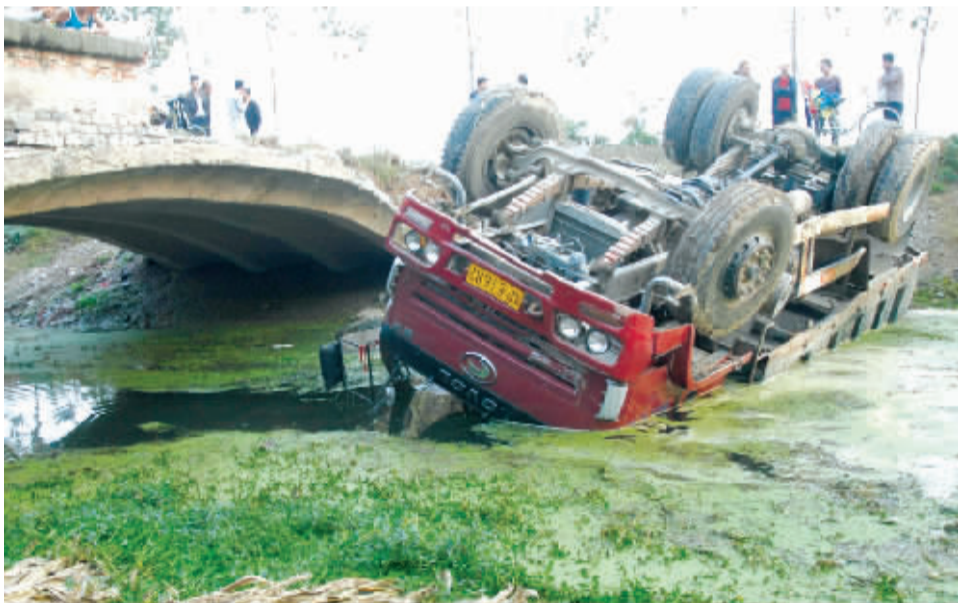
因,一直没有翻修。附近村民都希望有关部门能尽快将危桥修复,以方便他们出行。 线索提供 任先生
