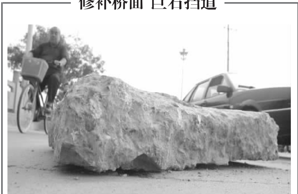
10月24日,在淮阳县东蔡河桥上,一块巨石横放桥面中央。据了解,这块巨石放在这儿已经有好几天了,是有关部门修补桥面时怕大桥从桥上通过轧坏路面而放置的。对此,不少市民认为,施工方怕车轧坏路面可以在桥头放置警示牌,放巨石挡道对行人和非机动车都有安全隐患。
