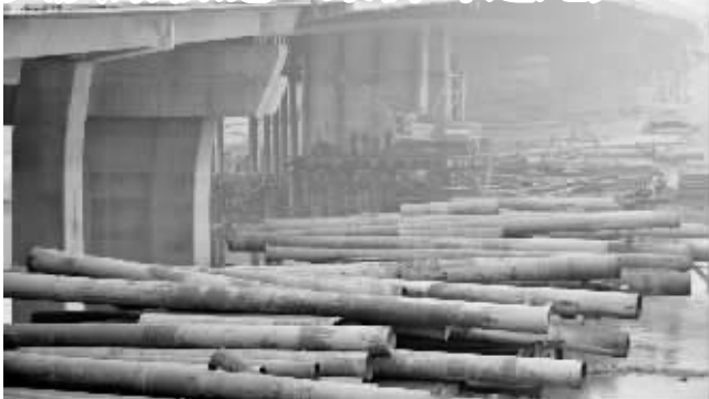
昨天,在沙颍河大庆路桥下,施工支架拆卸已接近尾声,这也意味着大桥建设即将全部完工。晚报记者 朱海龙 摄
