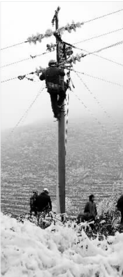
昭通市出现大范围的凝冻现象,14 日,大关县供电公司人员在维修受损电线。
