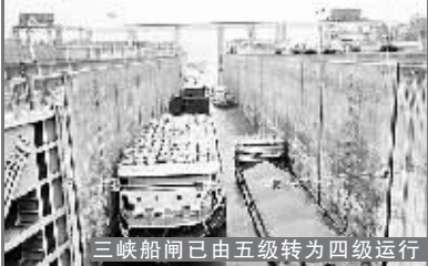
三峡船闸已由五级转为四级运行
