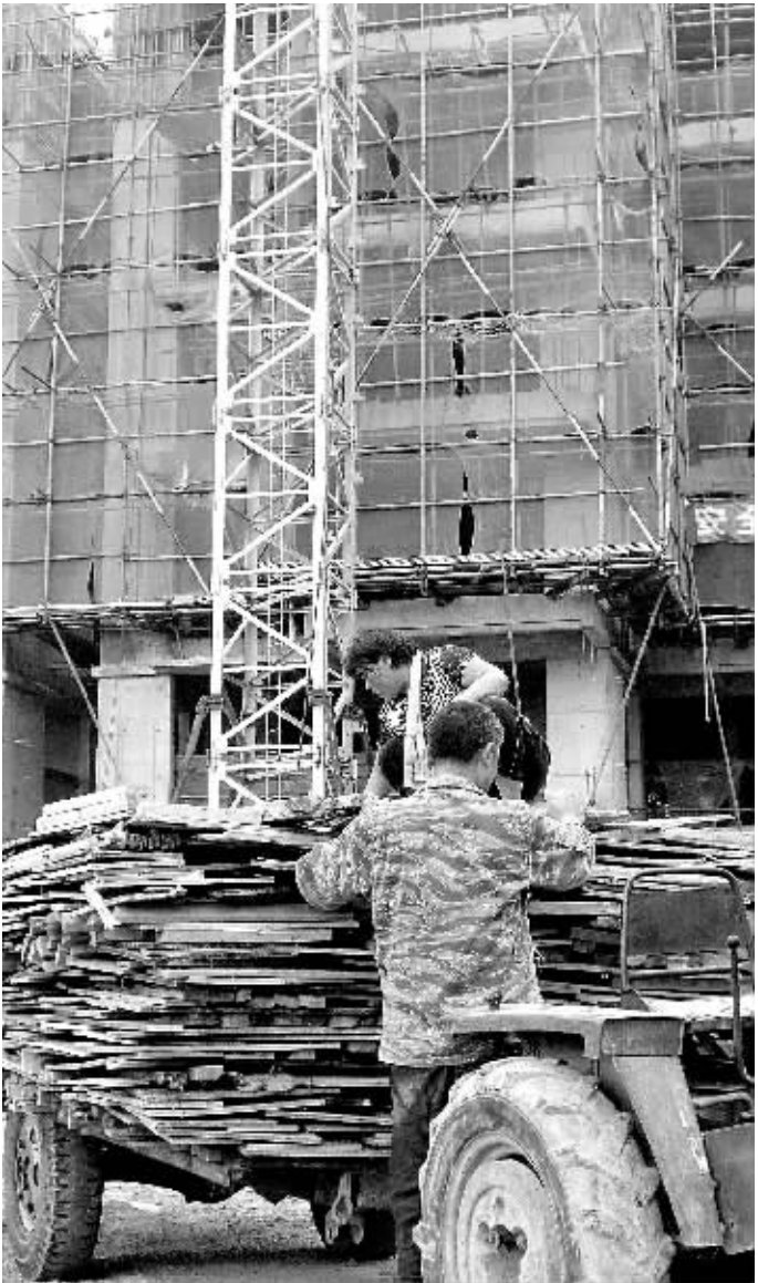
7月6日,工人正在馨莲茗苑工地上挥汗如雨地工作。据悉,馨莲茗苑一期一标段两幢11层小高层住宅即将销售完毕,一期二标段4幢18层高层住宅正在火热建设中。(赵世全 摄)
