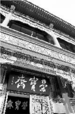
荣宝斋坐落在琉璃厂西街，是一座古色古香、雕梁画栋的高大仿古建筑
