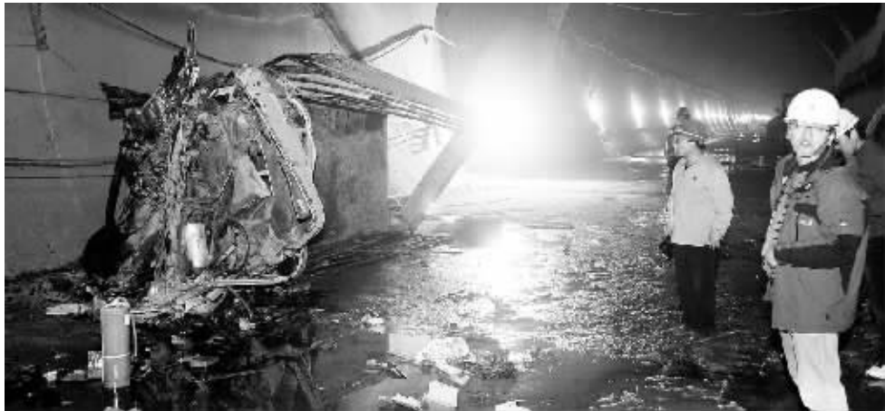
兰渝铁路黑山隧道吕家滩斜井内事发现场。新华社发
