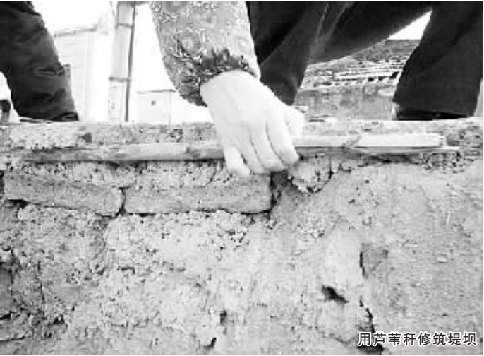
用芦苇秆修筑堤坝
