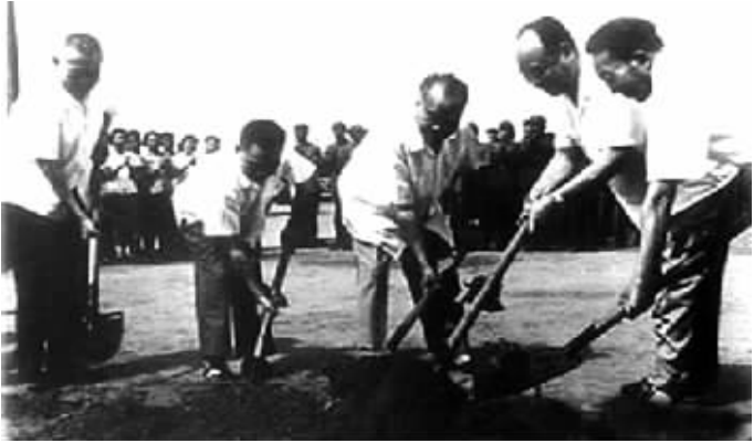
新中国第一条地铁开工奠基现场。
