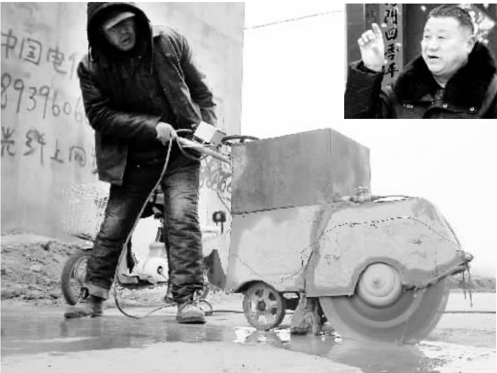
大图:2月13日，施工工人在修好的水泥路上切割“缩缝”。 小图:范应中
