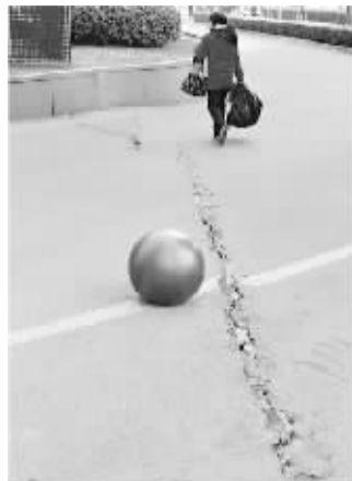
裂缝的宽度可以容纳约两根手指,长度在4米左右
