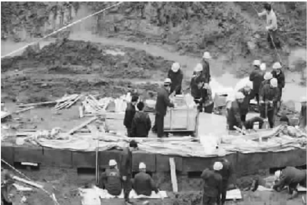
长沙开福区万达广场工地，工作人员正对古城墙进行整体切割转移作业
