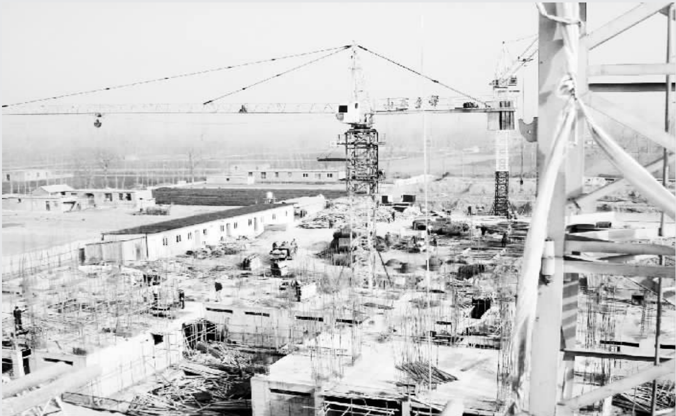
3月28日,施工人员在项城市保障性安居工程惠民小区施工现场紧张施工。惠民小区项目是项城市规模最大的安居工程项目,集经济适用房和廉租房于一体,总投资1.6亿元、占地87.2亩,建成后可提供经济适用房10万多平方米、廉租房6万多平方米。建设工期为两年,预计将于今年12月底竣工。晚报记者 金月全 摄
