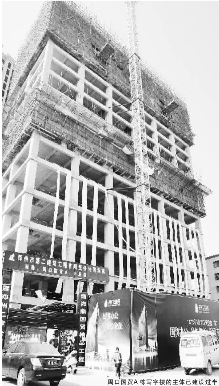
周口国贸A栋写字楼的主体已建设过半
