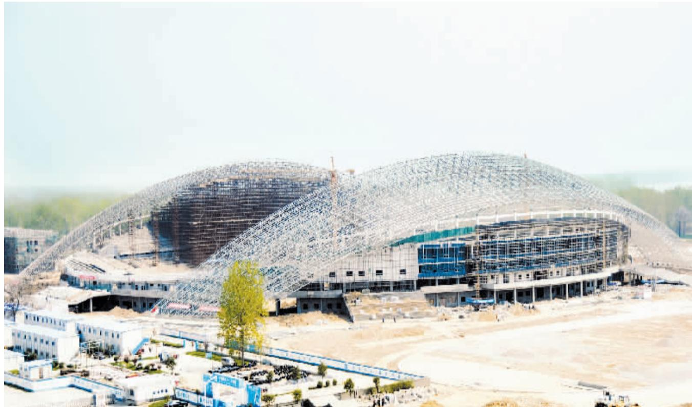
昨天,已顺利合龙的周口体育场东西两侧的框架钢结构犹宛如两条巨龙卧在东新区。据了解,承担施工任务的中建七局自去年10月份开始安装以来,建设者采用新技术新工艺科学施工,仅前两个月体育场西侧的首座框架钢结构就安全准确吊装到位。如今,雄伟壮观的体育场轮廓初现。
