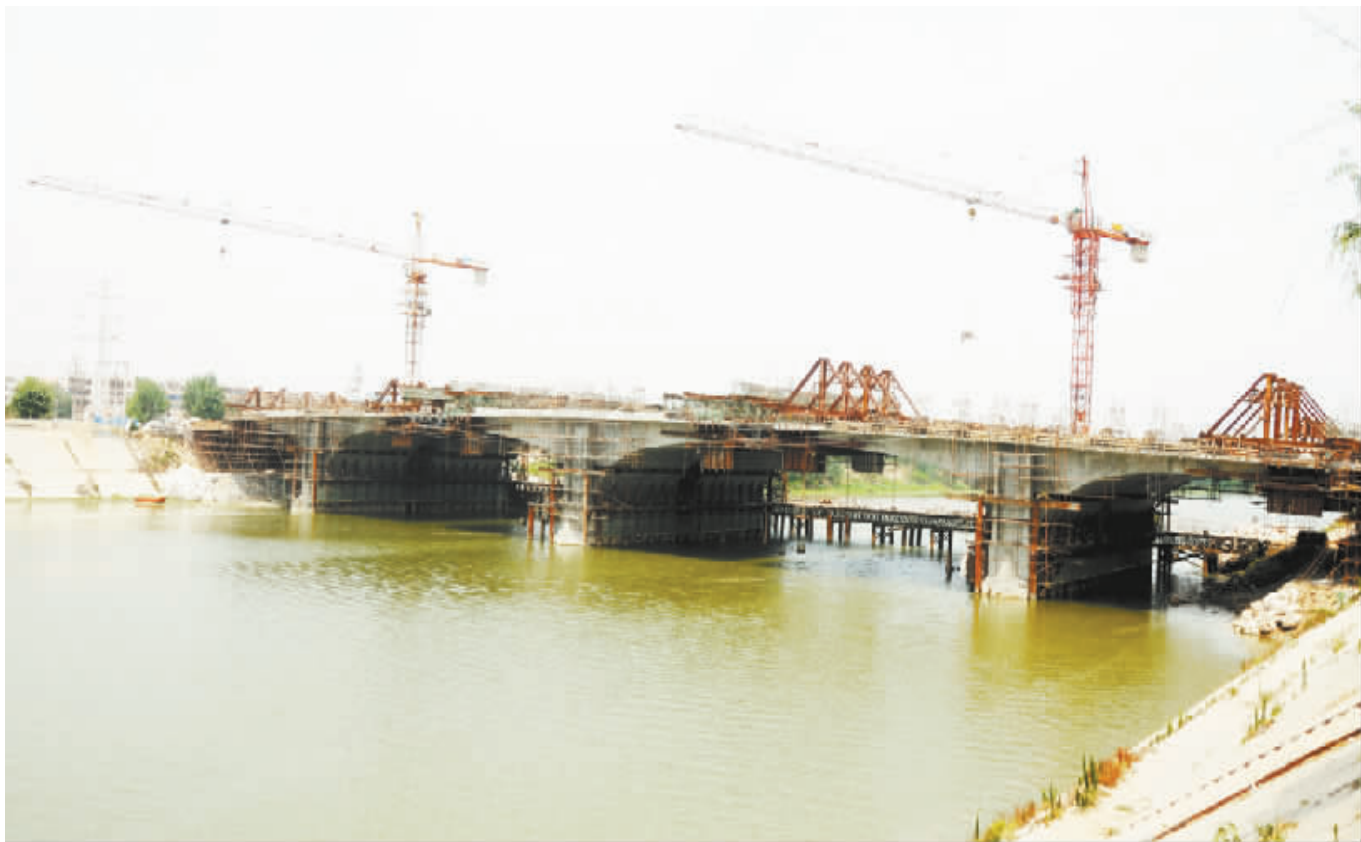
昨天, 周口沙颍河八一大道桥正在紧张建设。目前, 大桥已进入合龙施工, 预计 7 月初完成合龙, 保证按期建成通车。
