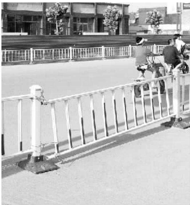
新修建的文昌大道（八一大道至中州大道段）宽敞平整，但路上的多处护栏遭到损坏，与周围美丽的环境极不相称。
