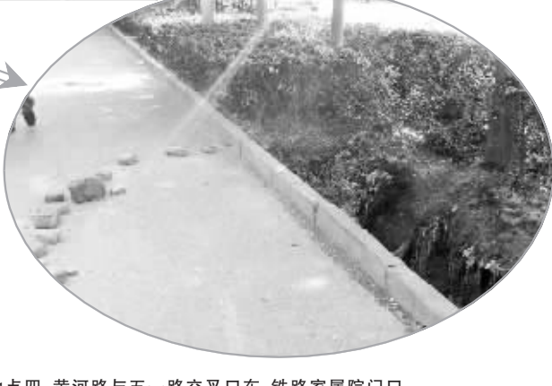
地点四:黄河路与五一路交叉口东,铁路家属院门口 损坏时间:1 个月左右 路面状况:正对着家属院门口的绿化带里,有一个深 2 米左右的坑,口径小,里面大,导致道路部分悬空。不知是哪位好心的市民,已经在路面上设置了“路障”,以免行人遭受其害
