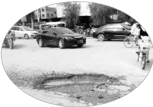
地点二:黄河路与工农路交叉口 损坏时间:1 年有余 路面状况:路面坑洼不平,三四个小坑连在一起,最深处约有 40 厘米,最浅处也有十几厘米
