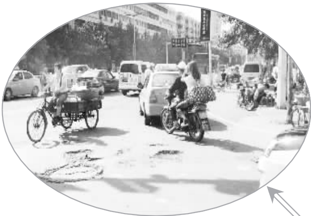
地点一:八一大道与交通大道交叉口 损坏时间:1 年左右 路面状况:拐弯处的路面已经被过往车辆碾得坑洼不平
