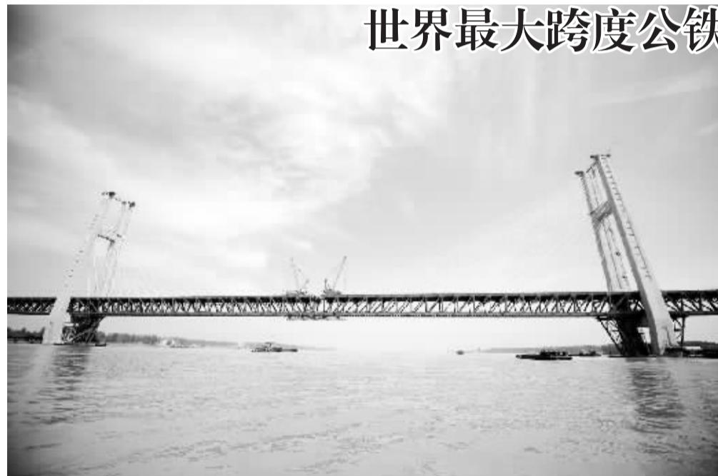
9月16日，长江上第6座公路铁路两用桥，也是目前世界同类桥梁跨度最大的黄冈长江大桥实现主跨钢梁合龙。
