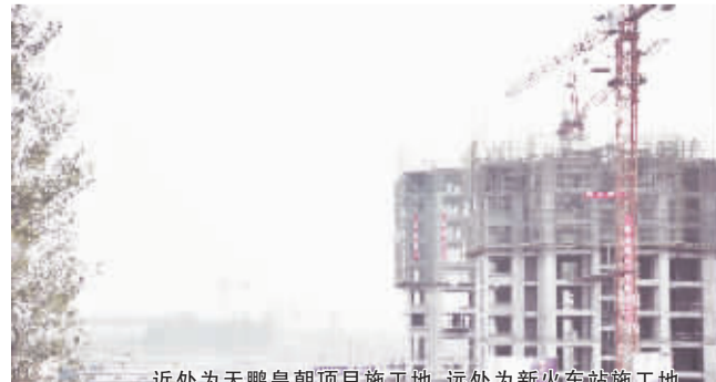
近处为天鹏皇朝项目施工地,远处为新火车站施工地
