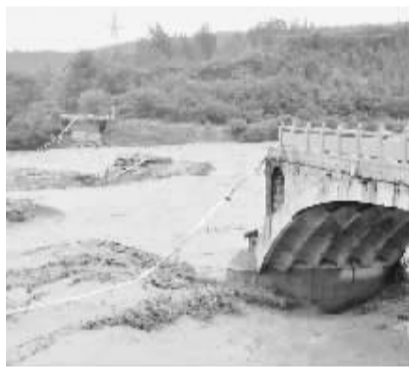
老青莲大桥垮塌事故现场
