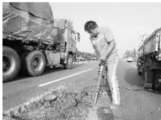
拆除破损路基
