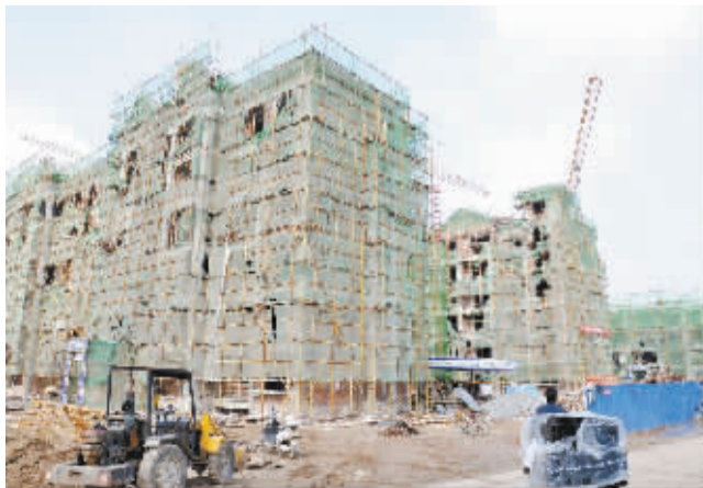
正在建设的二期工程
