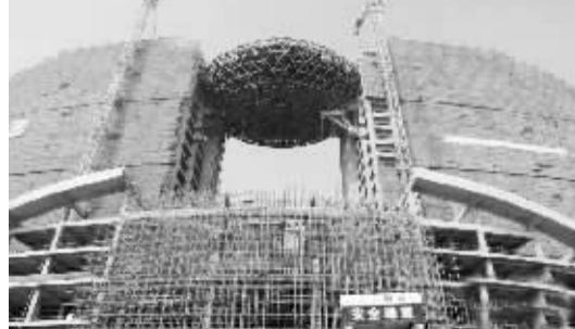
12月24日,一座外形酷似“鸟巢”的巨型空中椭球体结构亮相武汉,它是武汉国际博览中心洲际酒店顶部18层至20层的中间连接体,内部由两层钢桁架结构组成,高22米,长45米,宽40米,总重量约1500吨,提升高度达47米。该椭球体钢结构的体积、重量、提升高度在国内前所未有,被称为“中国第一椭球体钢连廊”。 张畅 摄
