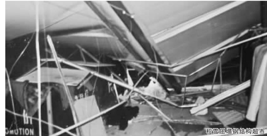
积雪压塌钢结构超市
