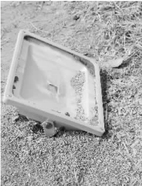
被破坏的地灯
