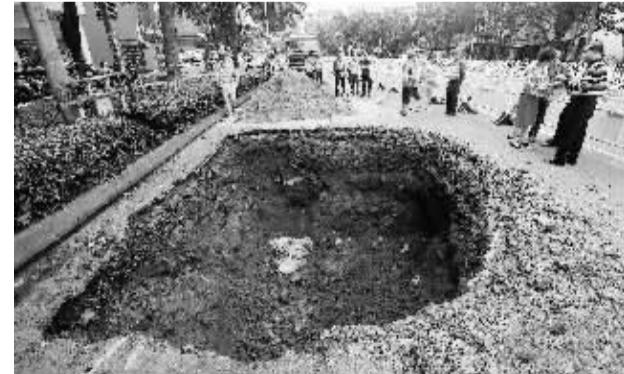
3月17日,海口市琼州大道一处路面发生塌陷,市政工作人员将塌陷路面表层清理后,出现一个直径5米、深4米的大坑。据海口市排水管道养护所负责人介绍,由于路面下方排水管道出现开裂漏水,土质松动,导致路面塌陷。目前,市政维修公司和海口市排水管道养护所的工作人员正在进行抢修。
