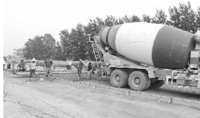
停车场正在进行地基浇筑
