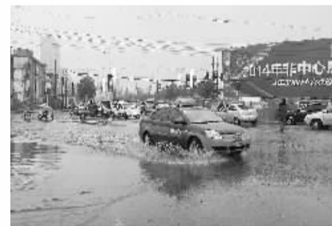
八一大道与文昌大道交叉口路面大量积水
