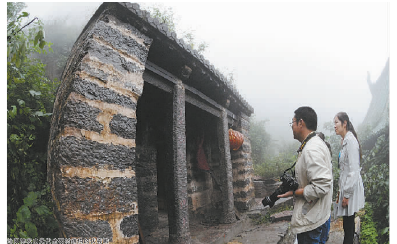
沁阳神农山元代全石材结构的伏羲殿
