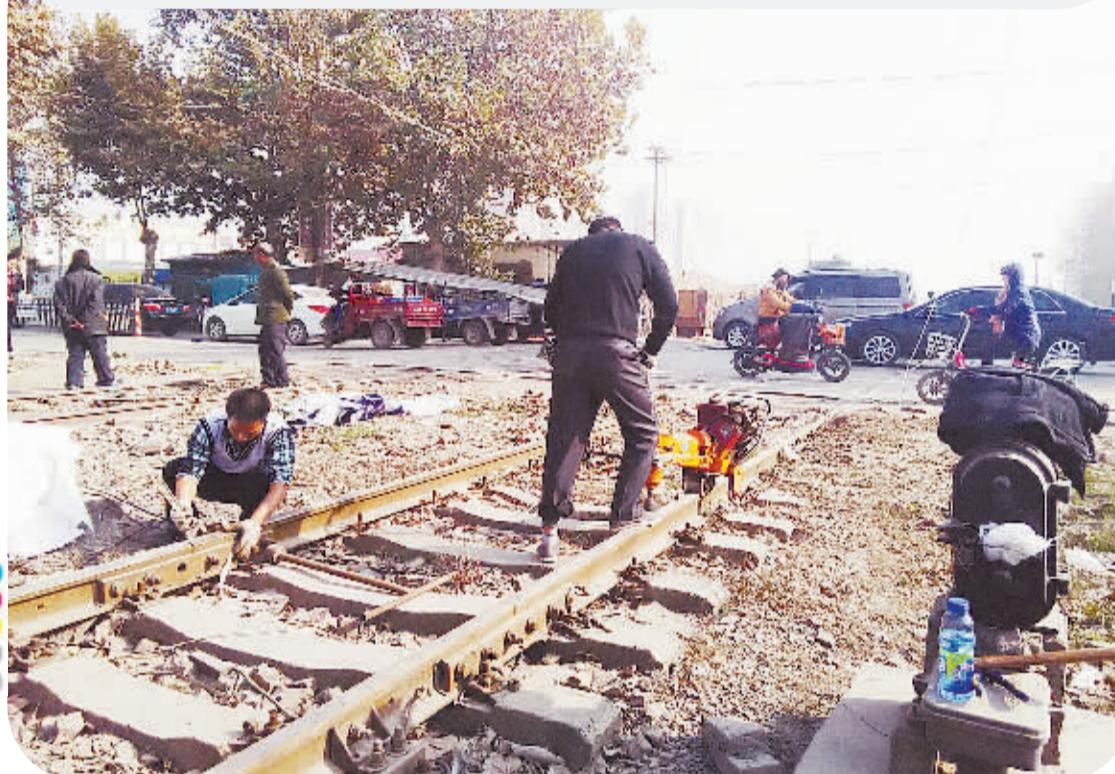
现场已经有数条铁轨的螺丝拆卸完毕。一名工作人员介绍：“八一大道上的铁轨拆除后，这里的铁路就不会再使用了。我们现在拆铁轨是为即将开始的道口改造做准备。我们今天拆除固定铁轨的螺丝，明天施工机械就可以轻松地移走铁轨和枕木，方便下一步道口改造的施工。”
