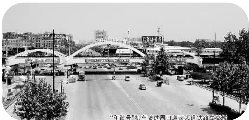
“和谐号”机车驶过周口迎宾大道铁路立交桥
