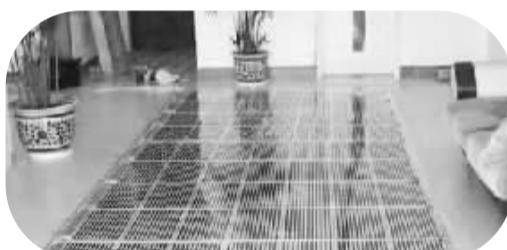
**真相:**地暖其实就是在地板中均匀铺设热媒,比如热水管、电缆等,利用热辐射的原理,达到取暖的效果。
