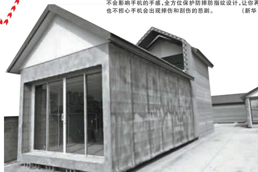
10幢3D(三维)打印建筑去年在上海张江高新区内揭开了神秘面纱。这些建筑的墙体是用建筑垃圾制成的特殊“油墨”，依据电脑设计的图纸和方案，经一台大型的3D打印机层层叠加喷绘而成，10幢小屋的建筑过程仅花费了24小时。(新华)
